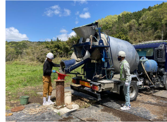
モルタル打設
