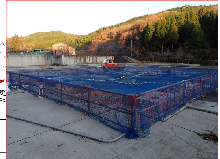
換気立坑口 安全ネット設置状況
