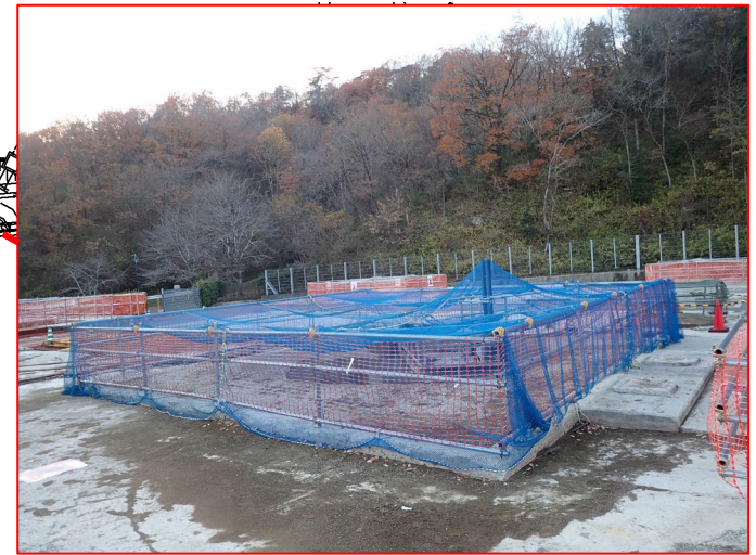
換気立坑口 安全ネット設置状況
